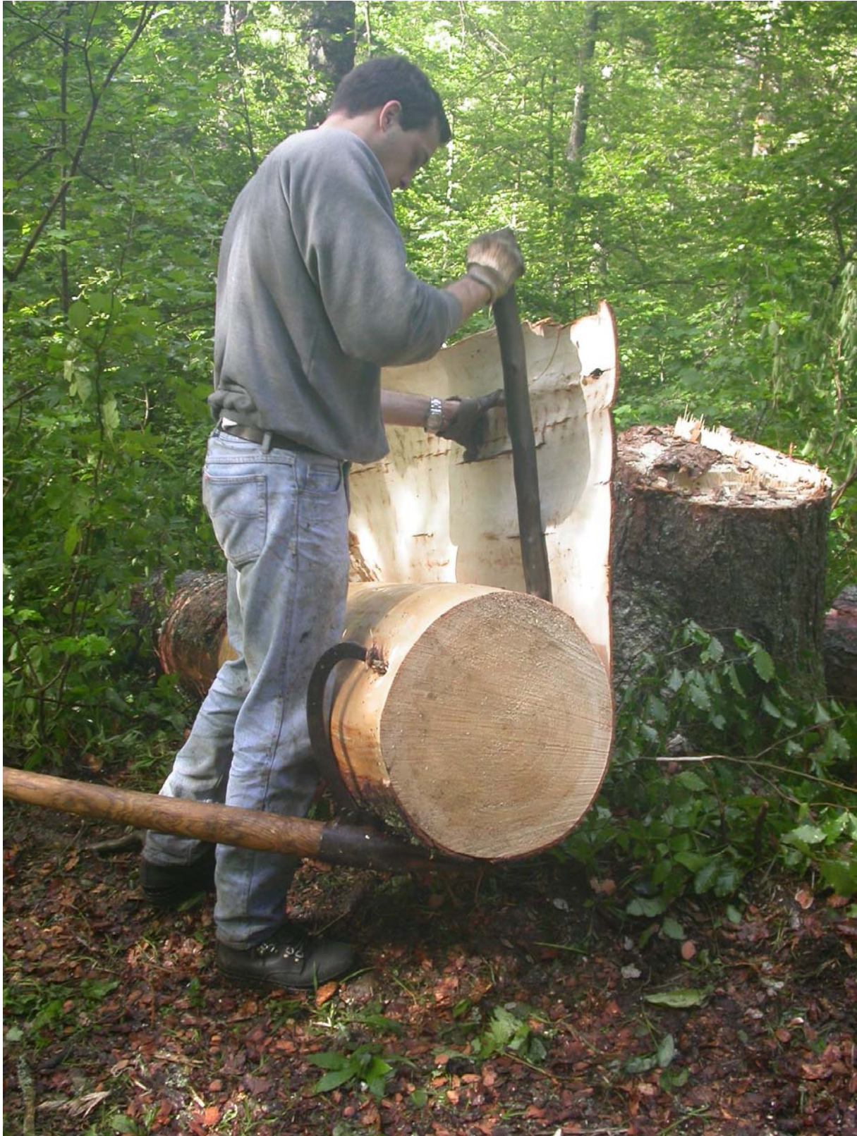
Levage d'une écorce
