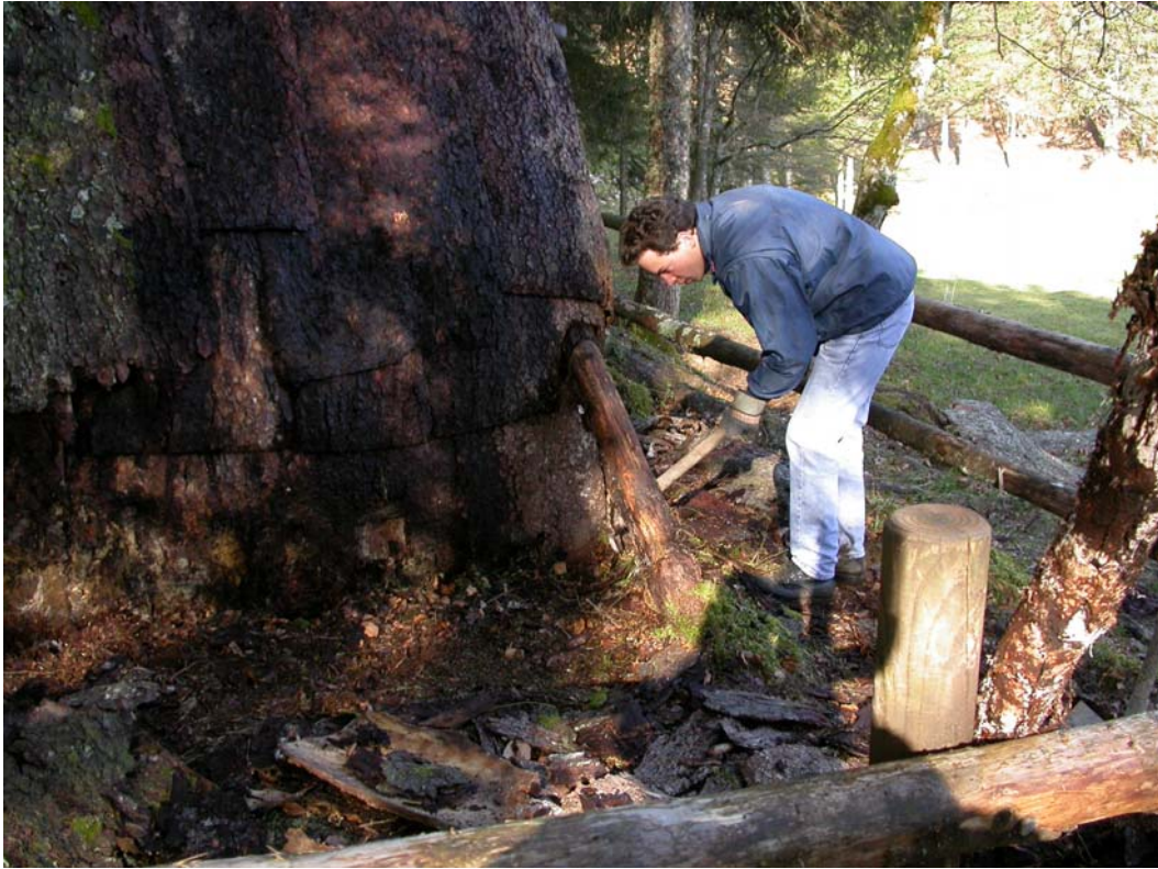
La cabane est ensuite débarrassée des écorces les plus abimées
