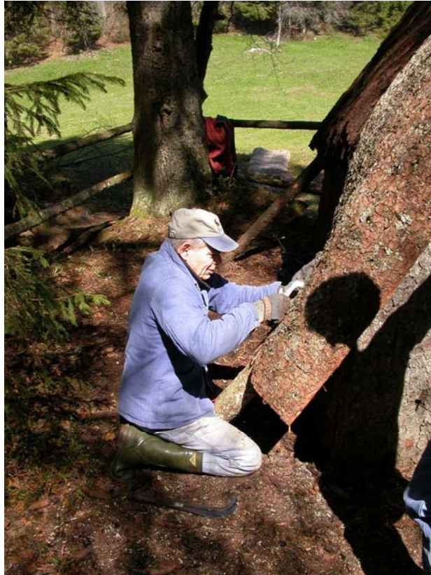
Mise en place des écorces sur les arcs-boutants
